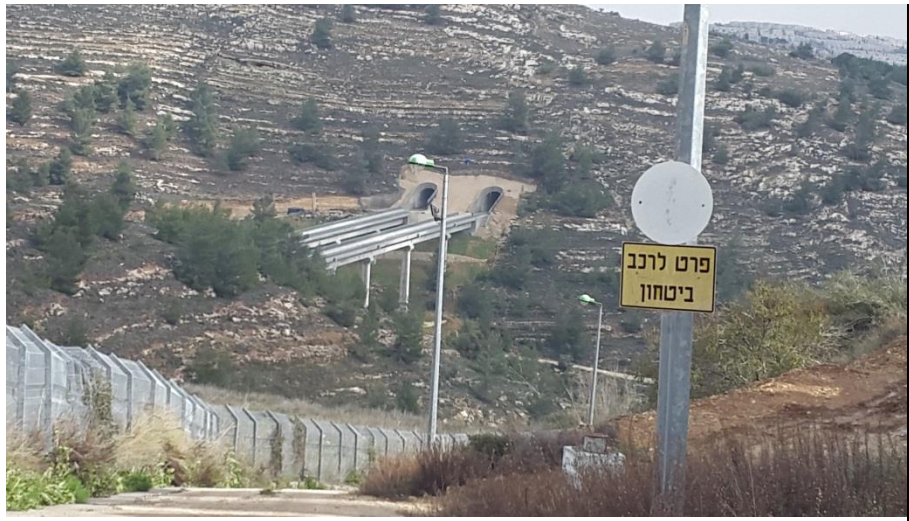
איור 3: גישור ומינהור קו הרכבת ירושלים-ת"א, על רקע גדר הביטחון של מבשרת ציון
